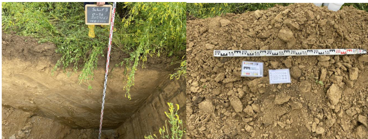
Abbildung 5: links: Baggerschurf 3, rechts: Aushubmaterial
