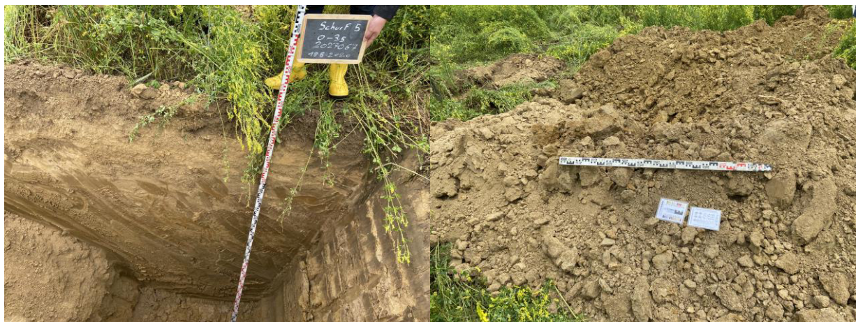
Abbildung 7: links: Baggerschurf 5, rechts: Aushubmaterial
