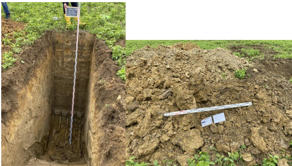
Abbildung 14: links: Baggerschurf 12, rechts: Aushubmaterial
