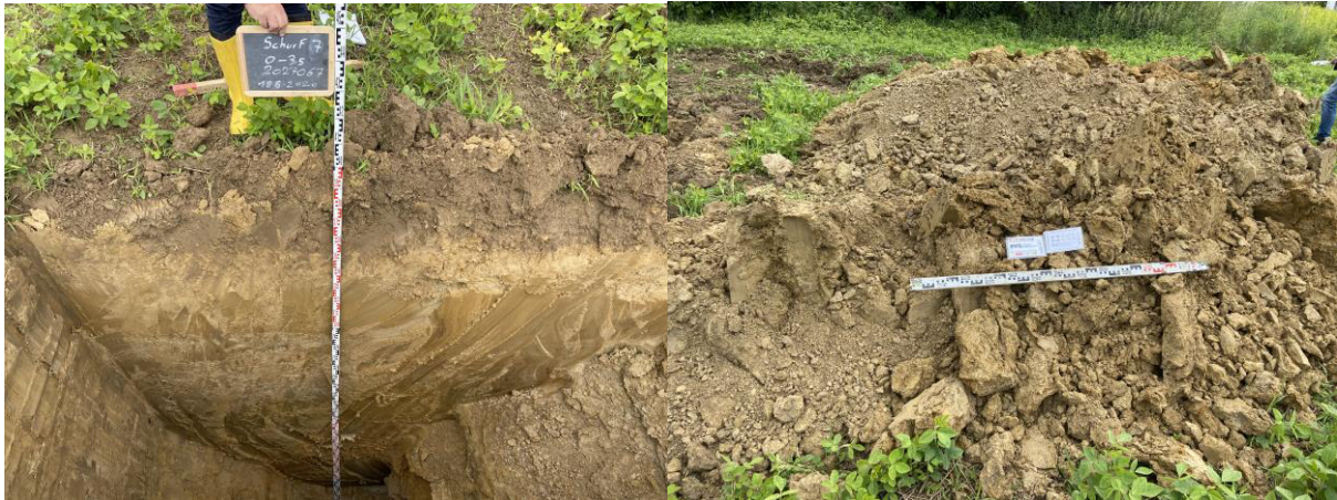
Abbildung 9: links: Baggerschurf 7, rechts: Aushubmaterial
