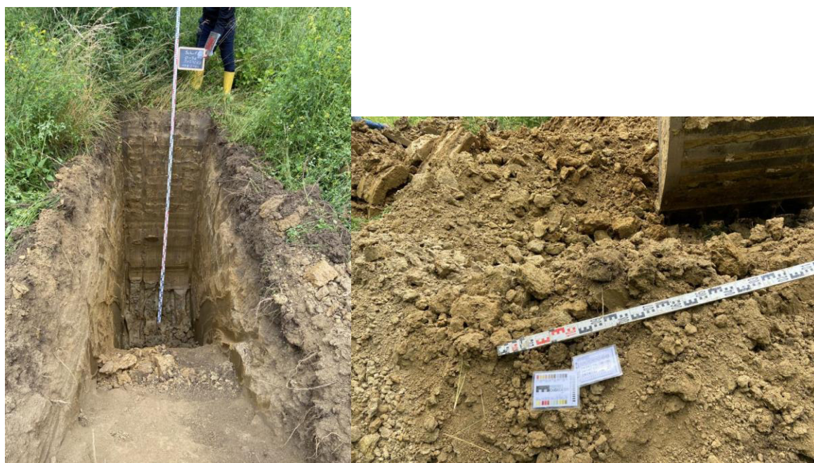
Abbildung 8: links Baggerschurf 6, rechts: Aushubmaterial
