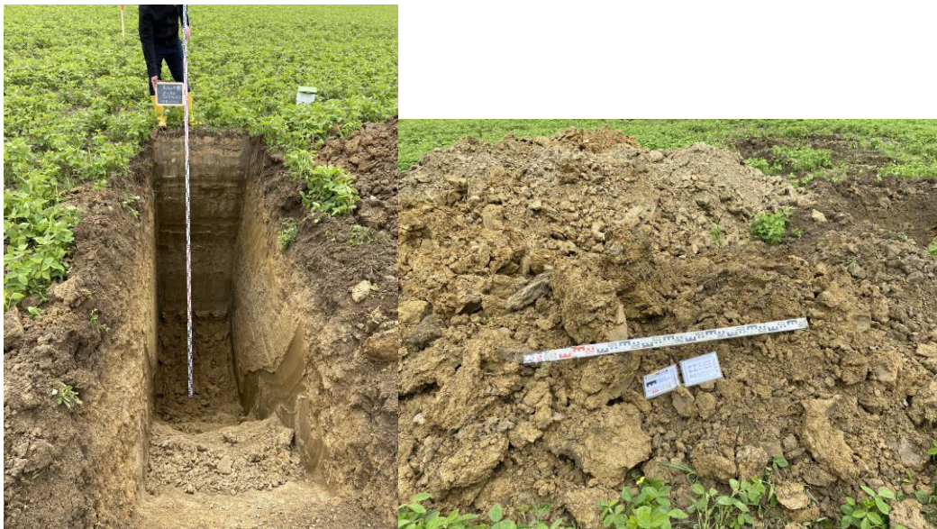
Abbildung 10: links: Baggerschurf 8, rechts: Aushubmaterial
