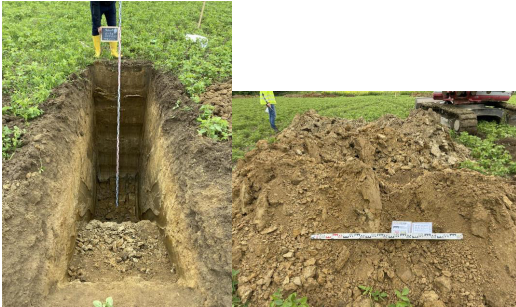
Abbildung 15: links: Baggerschurf 13, rechts: Aushubmaterial
