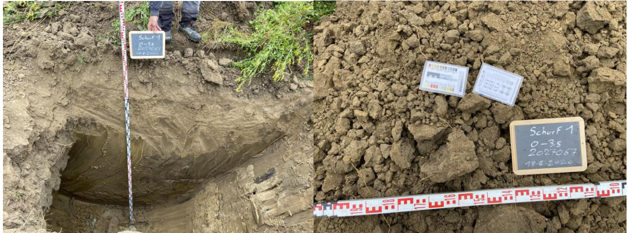
Abbildung 3: links: Baggerschurf 1, rechts: Aushubmaterial
